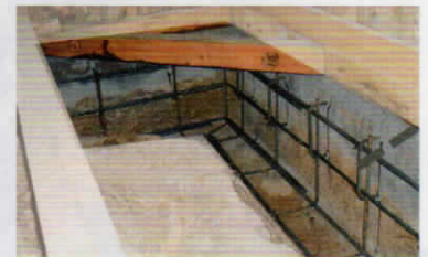
← 壁の補強工事 ↓ 基礎の補強工事
