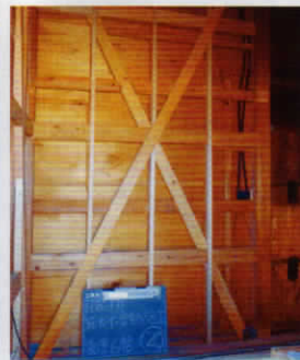
← 壁の補強工事 ↓ 基礎の補強工事
